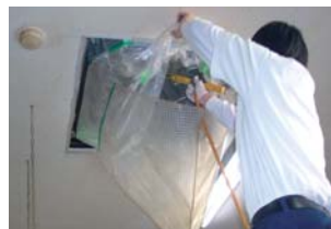
エアコンオーバーホール清掃
