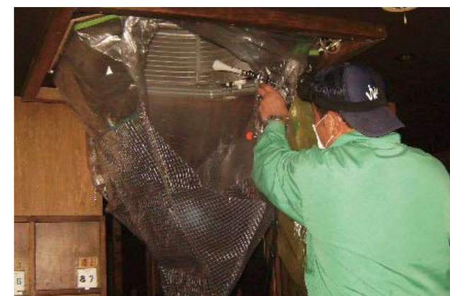
環境対応型エアコン分解洗浄作業の検証
