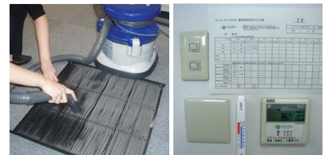
エアコンフィルタ清掃 温度チェックツール
