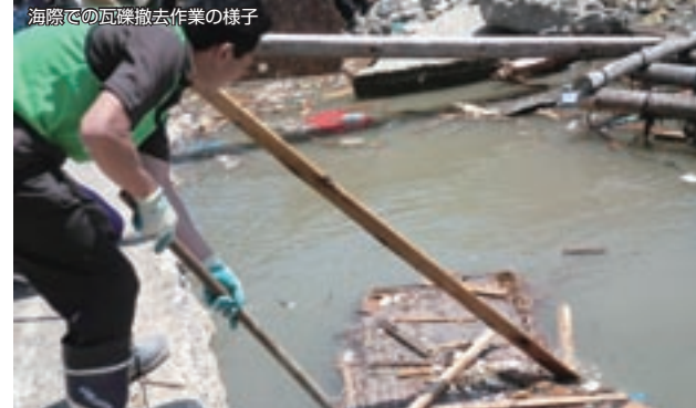
海際の瓦礫撤去作業の様子
