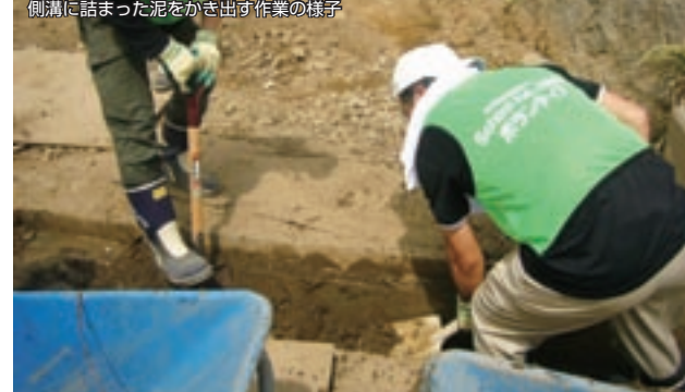
側溝に詰まった泥をかき出す作業の様子
