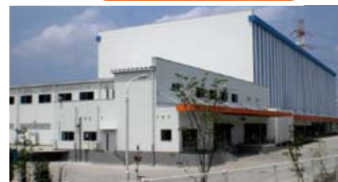
ワタミ手づくり厨房 日高センター
