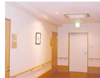
廊下の照明器具を絵画の間接照明と兼用させることで必要な照明器具を削減(レストヴィラ川口安行)
