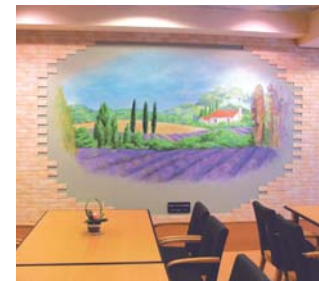
改装時に古い壁材に絵を描くことで仕上げ材を削減(レストヴィラ川口安行)
