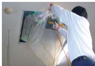
エアコンオーバーホール清掃
