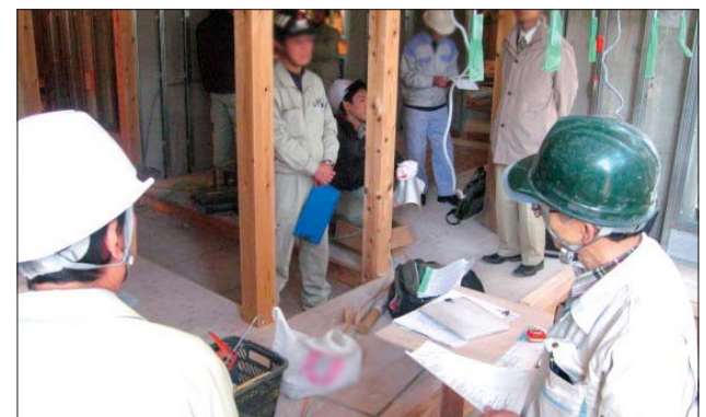
現場安全パトロール
