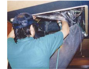
ワタミエコロジー「メンテナンス作業」
